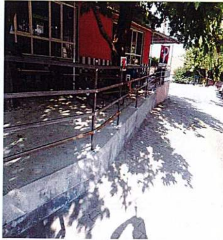
Akçakoyun mah köy kahve korkuluk montajı tamamdır
