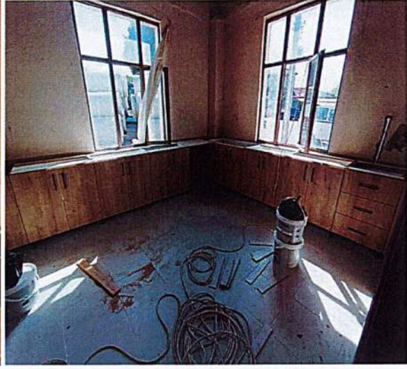
CANBAZ MAHALLE KAHVEHANESİNE DOLAP YAPIMI VE MONTAJI TAMAMLANDI
