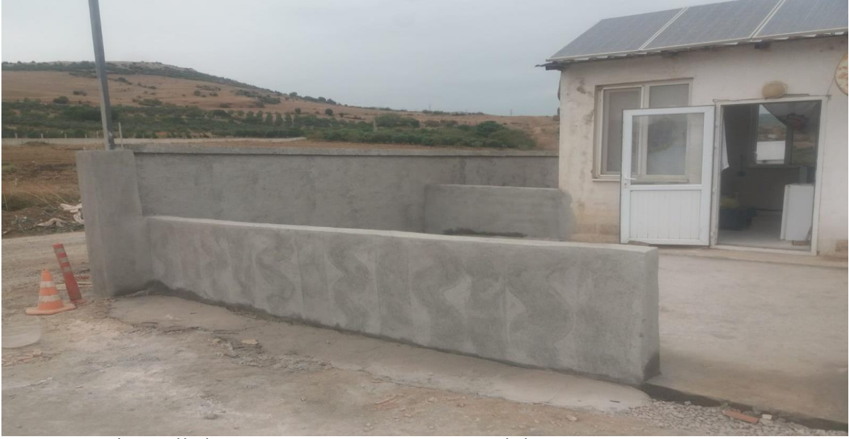
EKİNLİ MAHALLESİ CAMİİNİN ÇEVRE DUVARLARI YAPIM İŞİ
