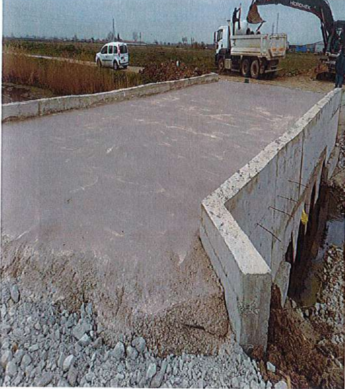
Canbalı Mahallesi 2 Adet Betonarme Köprü Yapım İşi
