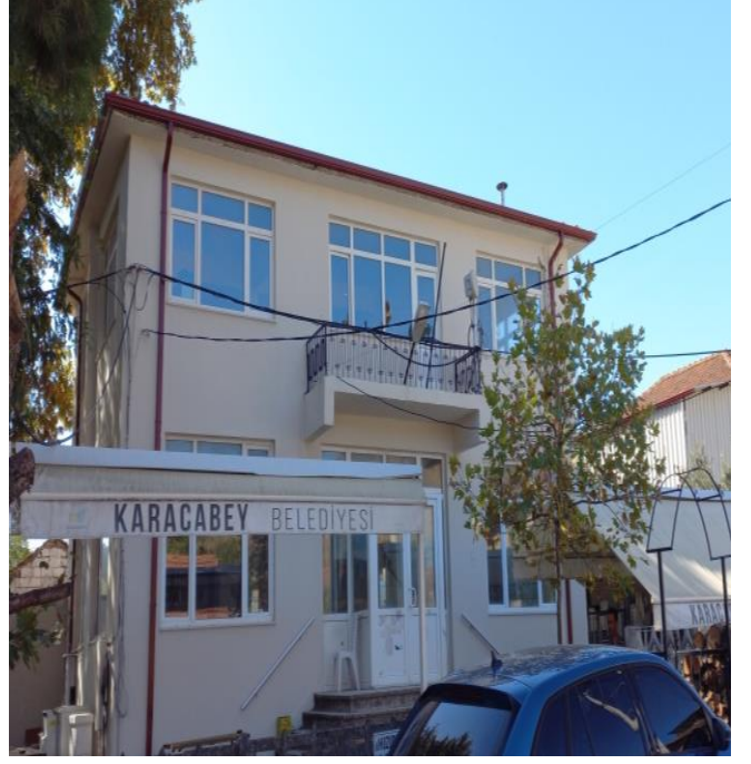
İnkaya Mahallesi Kahvehane Çatı Yapılması
