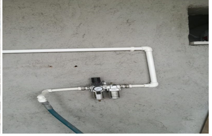
- Temizlik İşleri Müdürlüğü depo hava hattı yapımı
