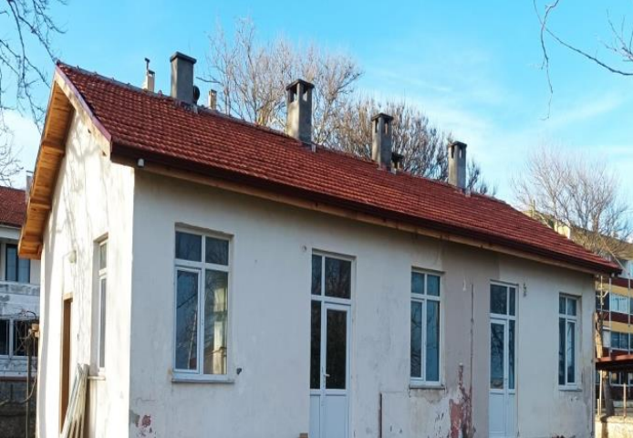
Yeniköy Belediye Evleri Çatı Yapılması
