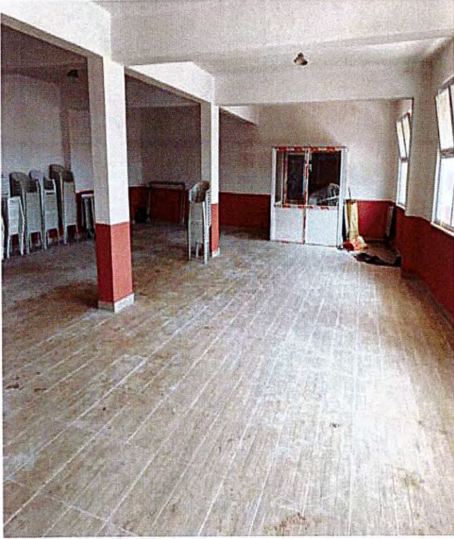
Çavuş Mahallesi Düğün Salonu Bakım Yapılması
