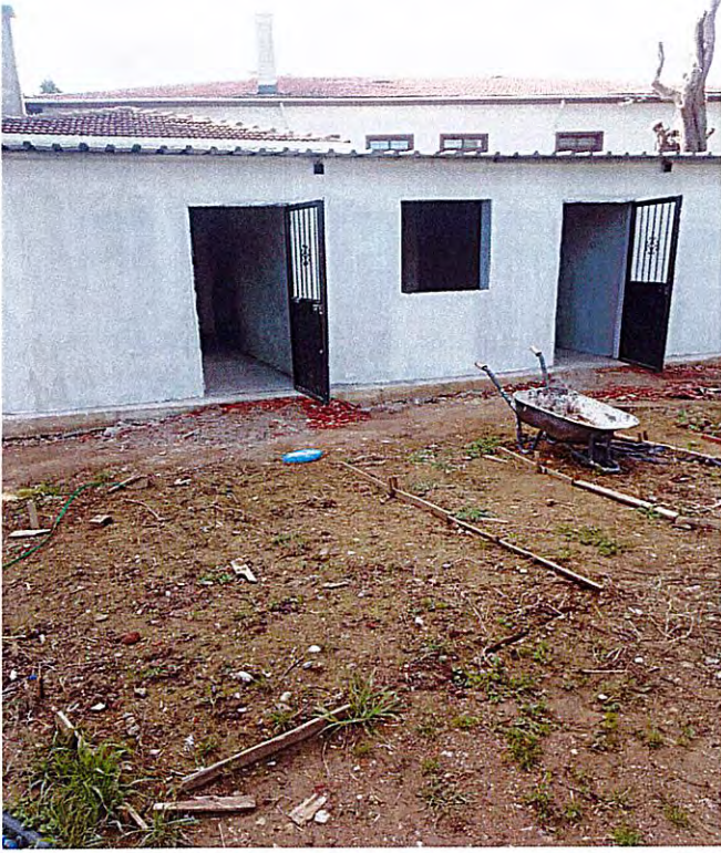
Harmanlı Mahallesi Okul Deposu Yapım İşi
